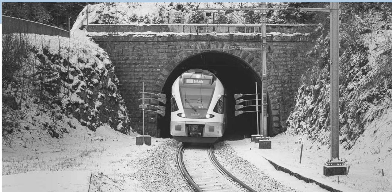
Libération du profil d'espace libre dans les quatre tunnels de Luche, Sauge, Loges et Mont-Sagne avec rénovation minimale et sécurisation des structure porteuses.
