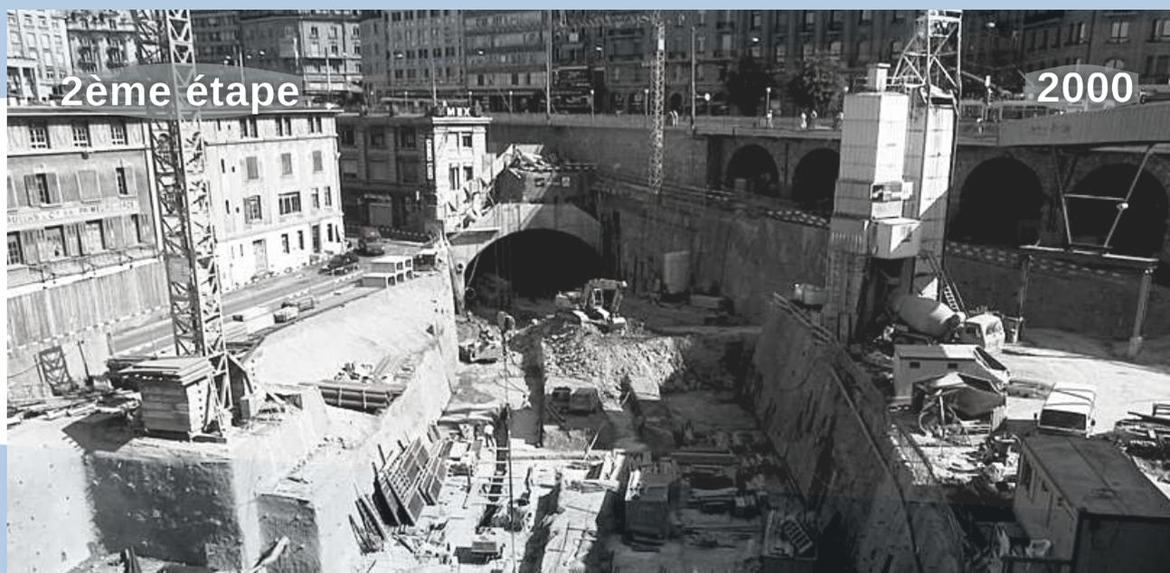
Percement du tunnel depuis la place du Flon en direction de la station souterraine de Chauderon.
